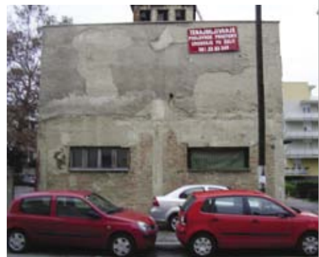
Stanje zaštićenog objekta _ prosinac 2009.
